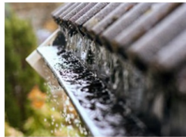
Gjør boligen godt rustet
